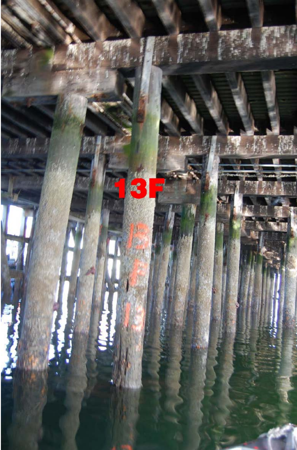
Pile 13F (Photo #364)
