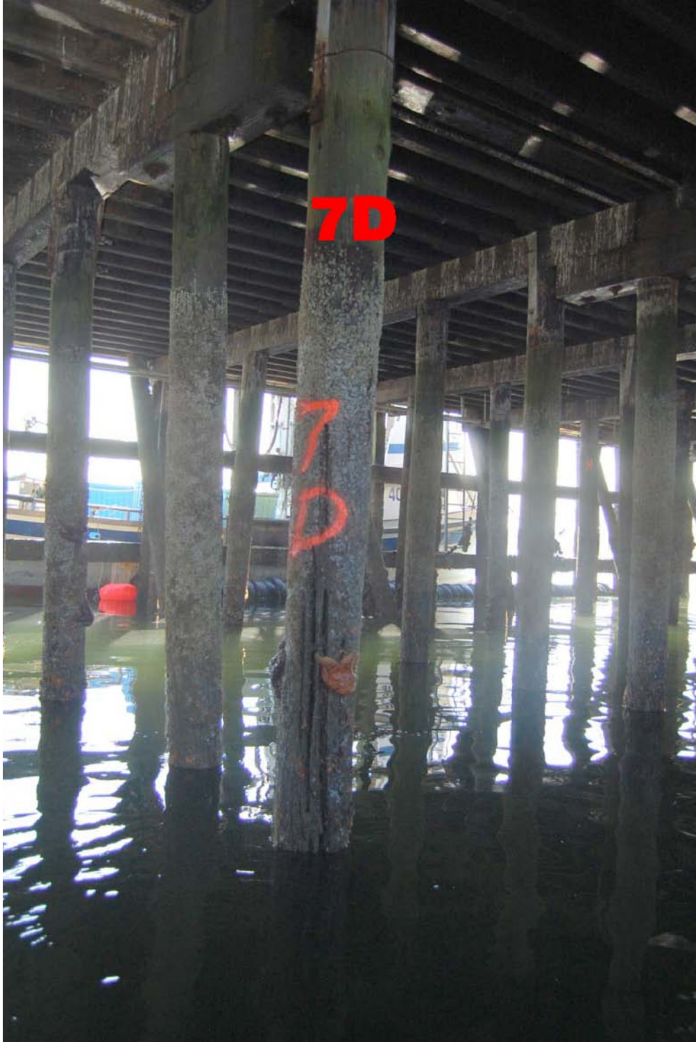
Pile 7D (Photo #360)
