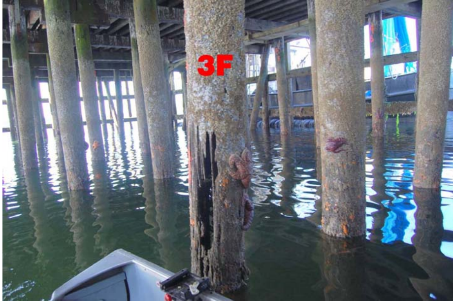
Pile 3F (Photo #365)
